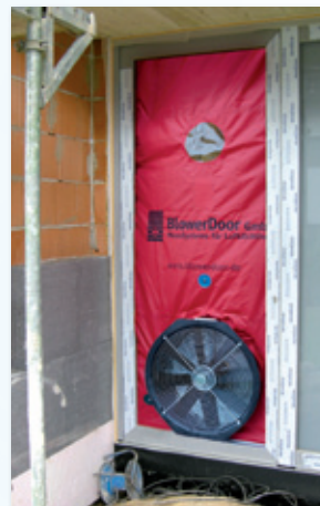
BlowerDoor Messung eines neu gebauten Einfamilienhauses
