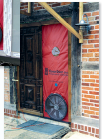
BlowerDoor Messung im Rahmen einer Fachwerksanierung
