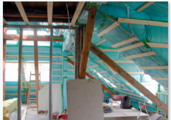
Die luftdichte Ebene ist noch sichtbar (Folie und Holzbauplatte): Der optimale Zeitpunkt für eine BlowerDoor Messung.
